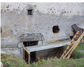
Om uit de bouwput te klimmen
